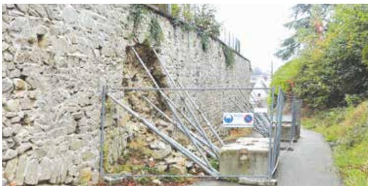
Suite à son éboulement, le mur du cimetière va être entièrement reconstruit en béton banché sur environ 60 mètres linéaires.
