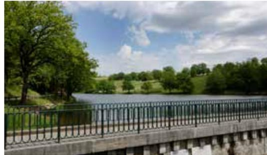
Le barrage du Vêrut a été construit entre 1889 et 1891 sous la municipalité de Thiollière de l'Isle. La première mise en eau a eu lieu en 1892. Il mesure 21 mètres de haut et 100 mètres de long pour une capacité de 1 60 000m<sup>3</sup>.
